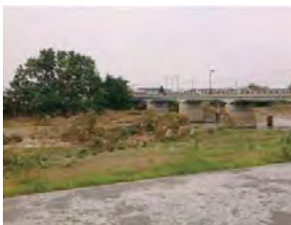
浸水後の、岩木川河川敷 増水により木がなぎ倒されている。（富 士見橋）
